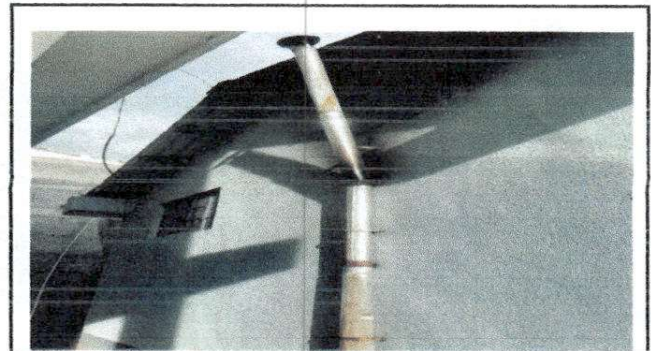
Foto 10: Sustitución de chimenea de metal
