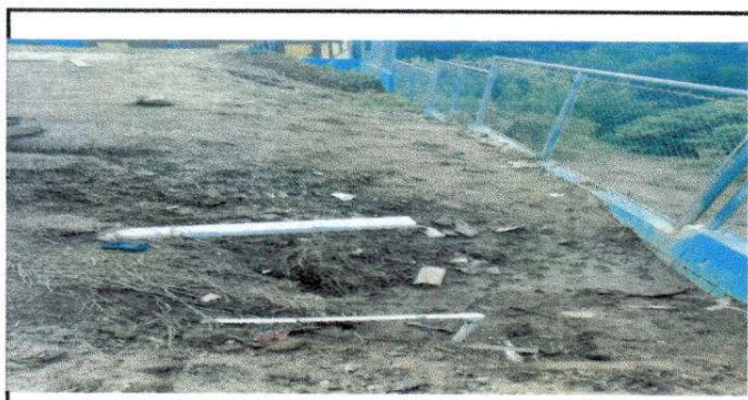
Foto 5: Sustitución de tubería PSI línea principal de aguas negras
