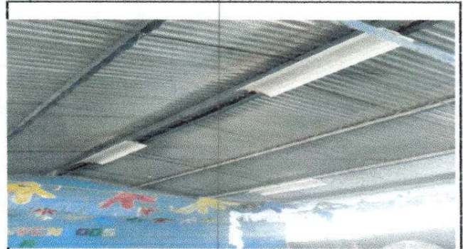
Foto 8: Reparación de sistema eléctrico
