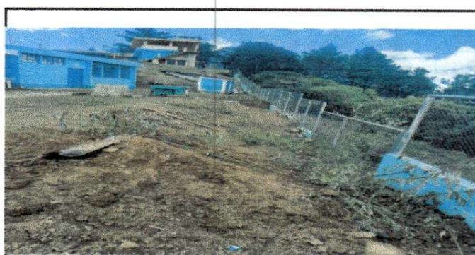
Foto 6: Reparación de muro perimetral de block
