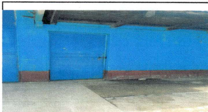
Foto 3: Sustitución de puerta.
