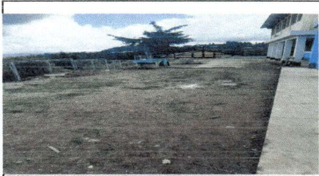
Foto 7: Losa de patio
